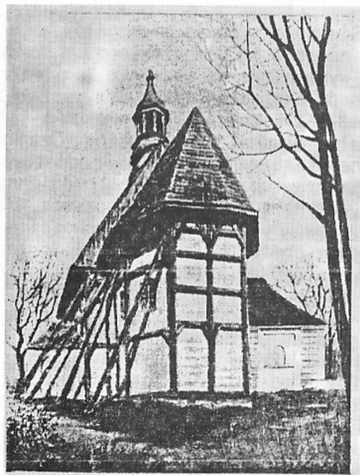
KOŚCIÓŁ W SKORASZEWICACH PRZED PRZEBUDOWĄ
